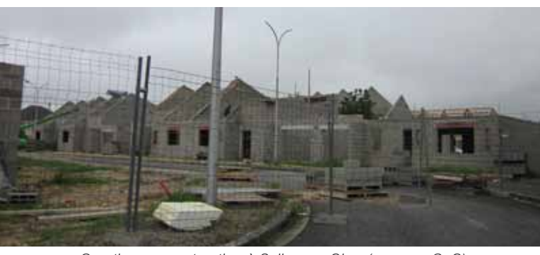
Quartier en construction à Selles-sur-Cher (source : GZC)
