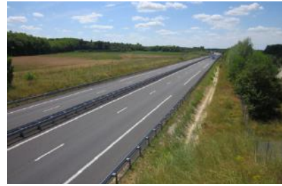
Autoroute à Méhers
