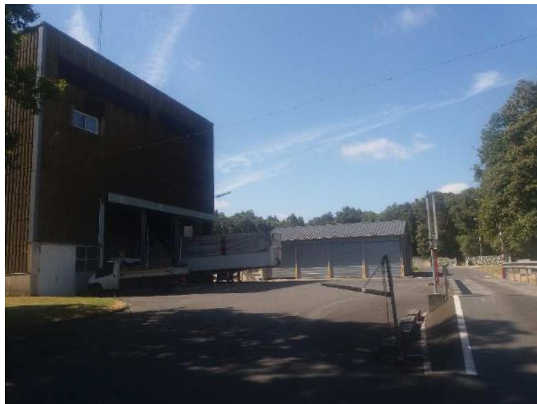
Photo : Centre de Transfert des Déchets de Choussy. Source : BIOTOPE, le 03/08/2016
