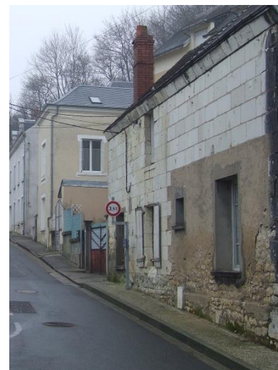
Exemple d'intervention peu respectueuse du bâti ancien
