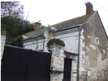
Murs en moellons calcaire, toitures en ardoise et utilisation du tuffeau en chaînage d'angle
