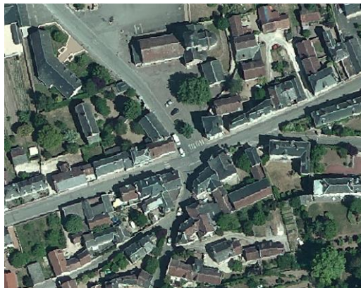
Trame bâtie en centre ancien, exemple de Saint-Georges-sur-Cher
